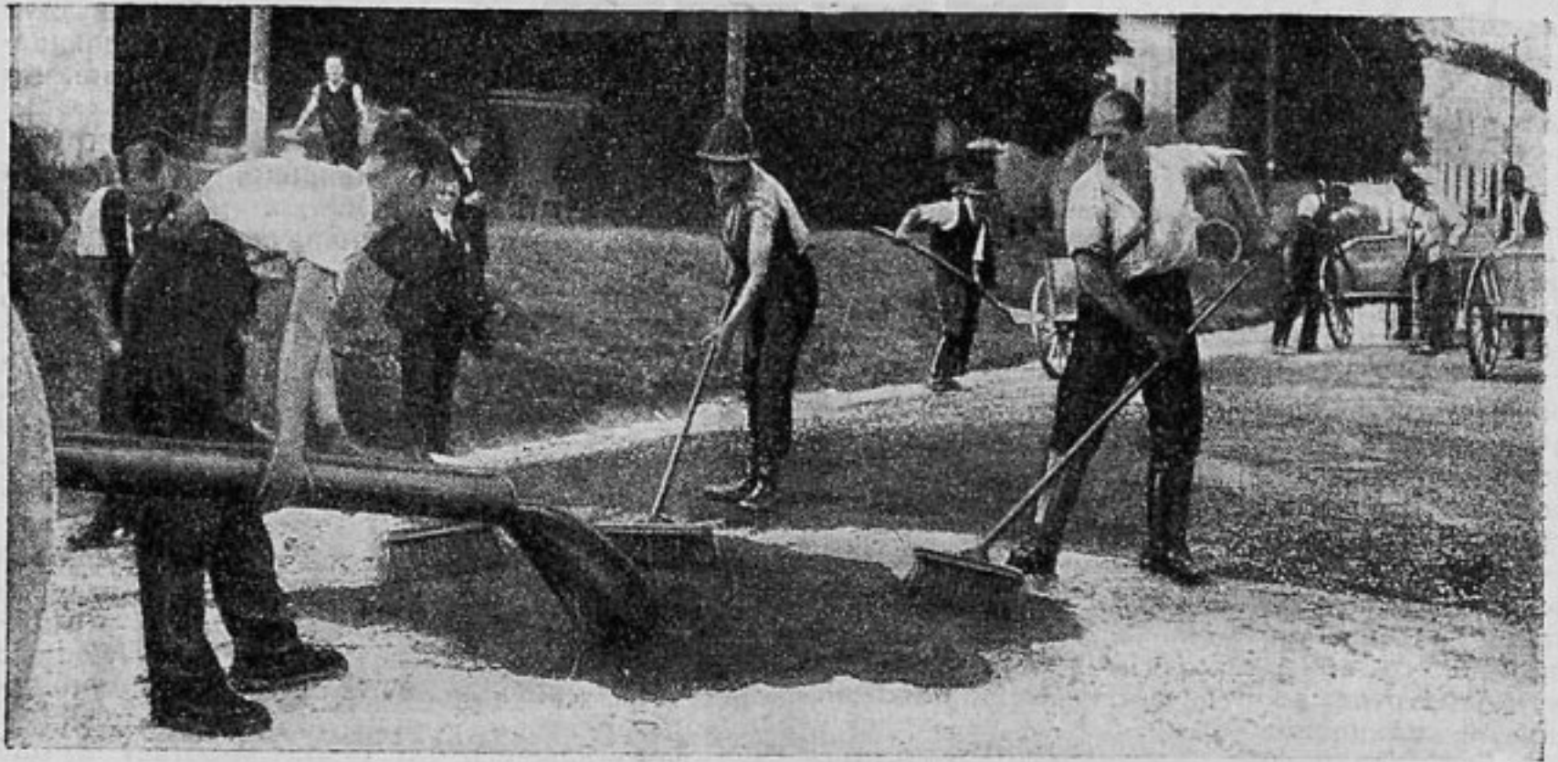
Общий вид работ с холодным асфальтом
